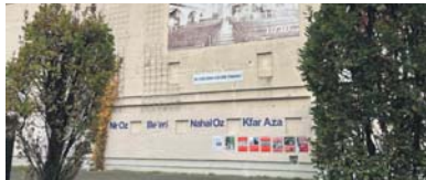
Der Hochbunker in der Friedberger Anlage – außen und innen (Bild unten)
